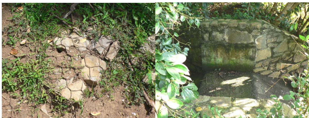
Figure 4 : Gabions et déversoir de crues aménagés à l'exutoire du lac
