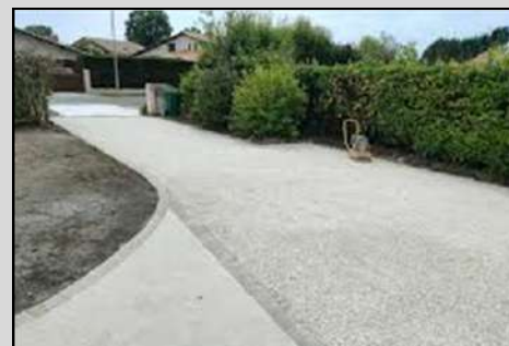
Revêtement en sable stabilisé - ©Garden Park Concept
