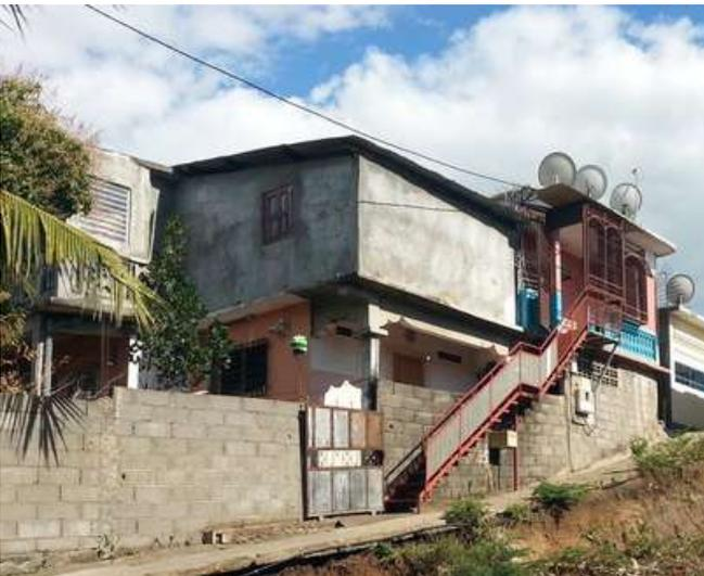
Elles constituent le stade d'après des précédentes. Les murs ont été montés en parpaings puis crépis. Un escalier extérieur permet d'accéder à l'étage. Et une toiture en bois sous tôle a été réalisée. L'étage sert soit pour un membre de la famille, soit pour la location.
