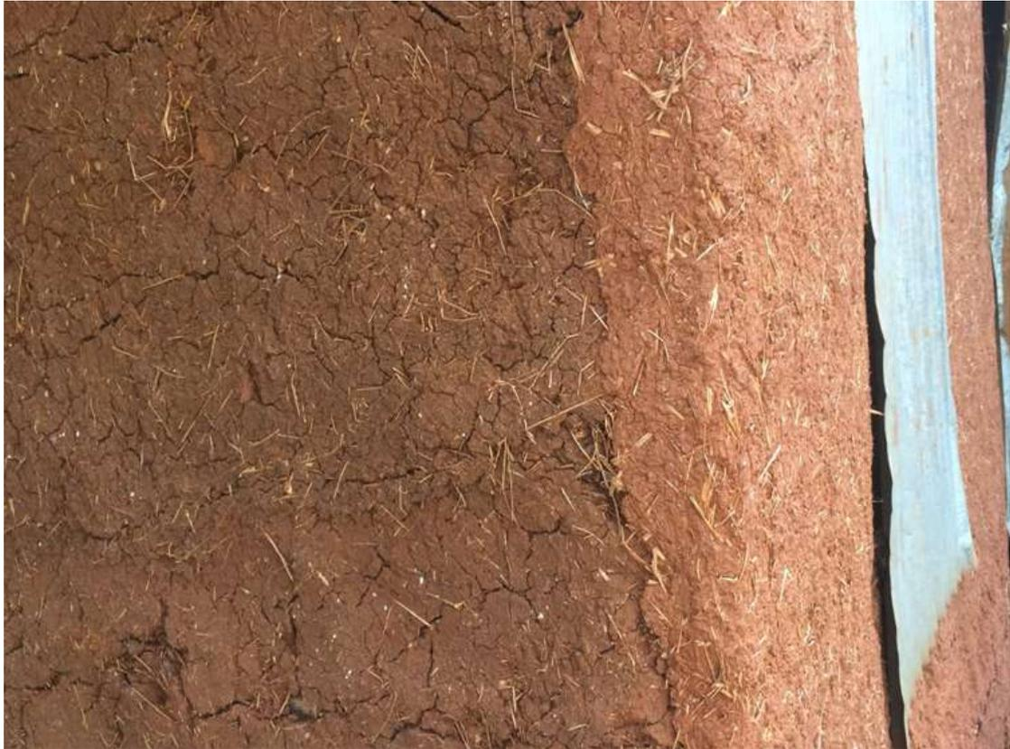
*Figure 3: Les murs en terre, devenus très rares, font largement appel aux bioressources locales: bois ronds d'ossatures, lattes de bambou formant l'armature interne, fibres (paille de riz, feuilles de bananier...) mélangées à la terre et l'eau pour le torchis.*
